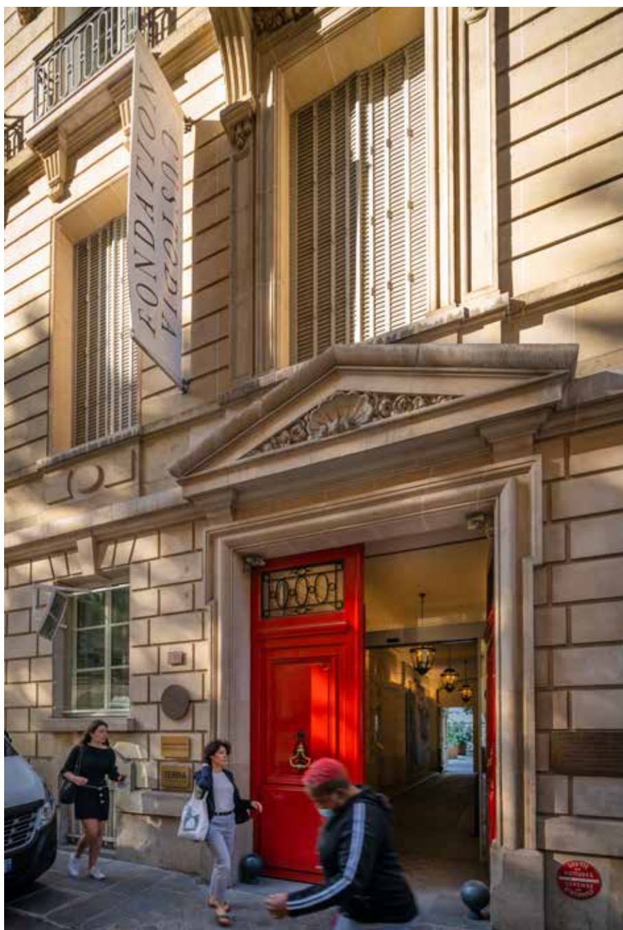
La façade de la Fondation Custodia, aménagée dans un hôtel particulier de 1743, l'ancien hôtel Turgot, rue de Lille à Paris. © photo : Jannes Linders
